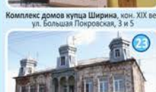
Комплекс домов купца Ширнина, кон. XIX в. ул. Большая Покровская, 3 и 5
